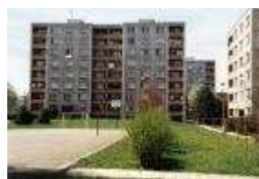
obr.3.9 a 4.0 panelových domů
